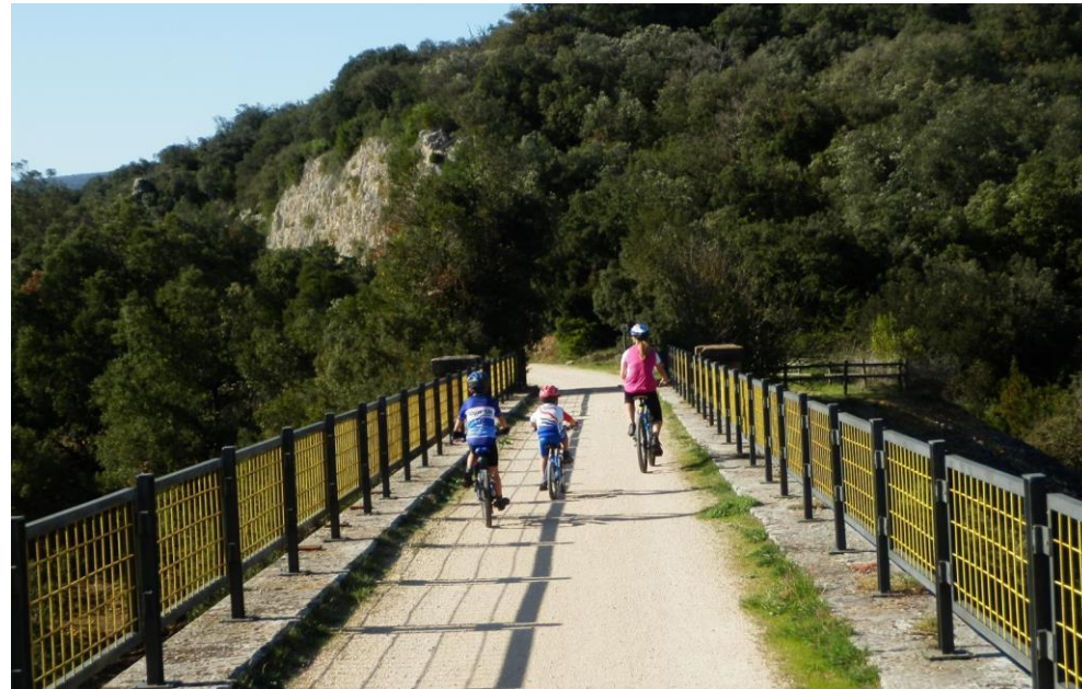
Vía Verde del Ferrocarril Vasco Navarro
