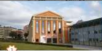
7 ILGONER ERAIKINA EDIFICIO ILGNER
