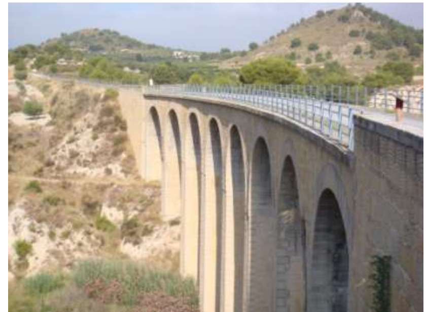
LA LUZ VIADUCT
