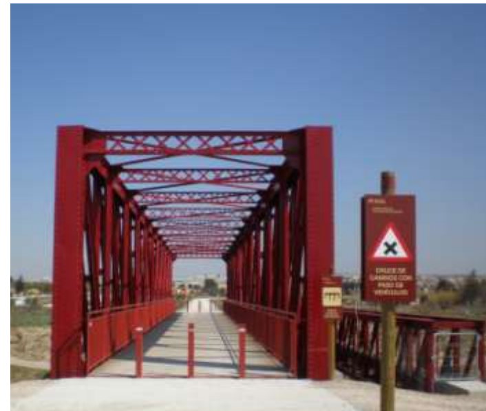
BRIDGE OVER RIO SEGURA
